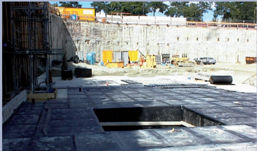
Verlegung von CIMAX
